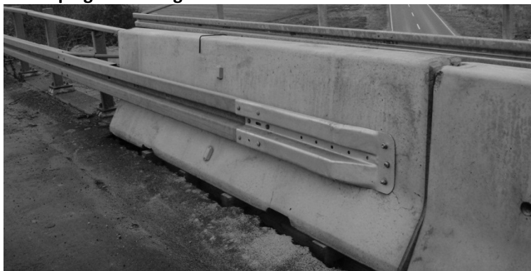
Figur 7.9 Eksempel på overgang mellem trafikvænet og autoværn.!
