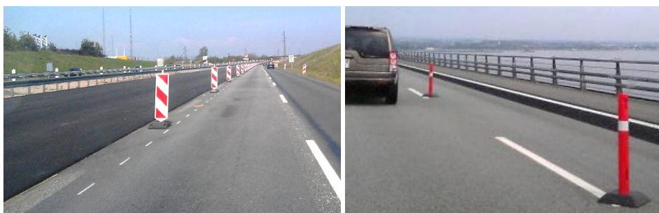
Figur 6.18 Eksempler på længdeafspærring mellem arbejdsområde og kørebane.
