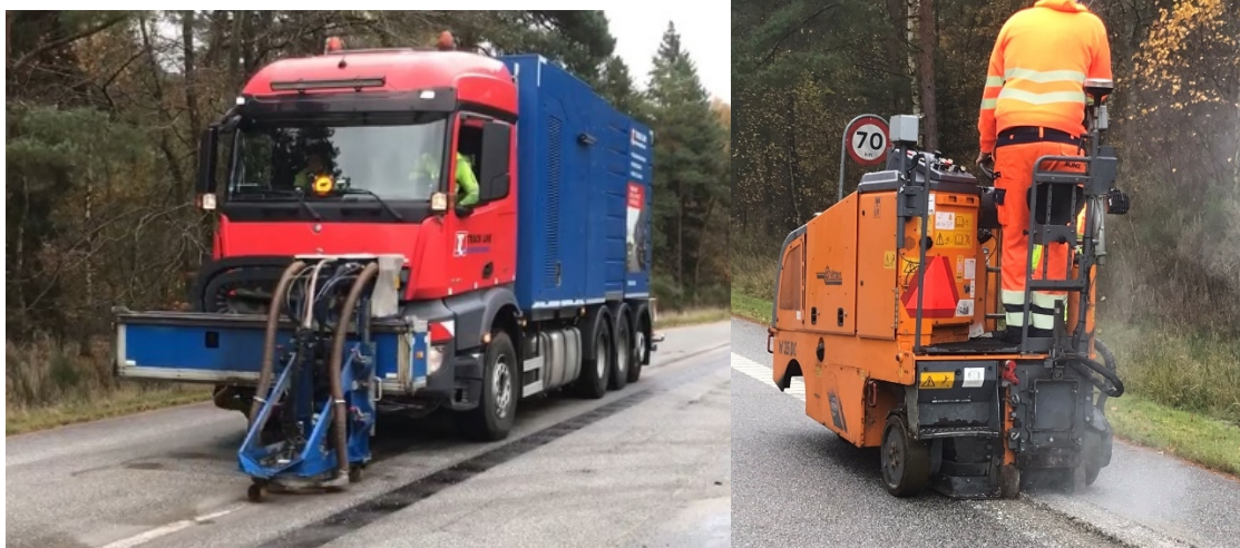
Figur 8.6 Eksempler på metoder til skånsom fræsning af kørebaneafmærkning med vandspulefræser og valsefræser.
