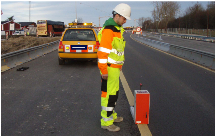
Figur 8.9 Eksempel på kontrol af kørebaneafmærkningens retrerefleksion ved anvendelse af retrometer.
