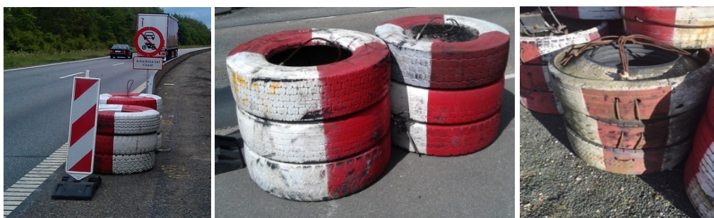
Figur 7.14 Eksempler på dæksøjler som er forsvarligt sammenkoblede.
