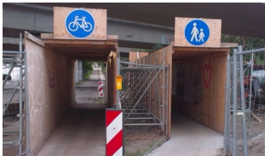
Figur 5.31 Eksempel på interimssti ved vejarbejde.
