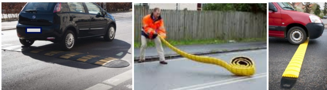
Figur 7.18 Eksempler på midlertidige bump.
