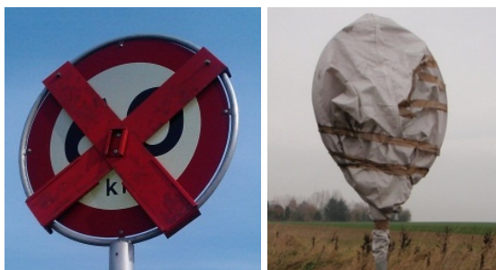
Figur 8.3 Eksempler på annullering af færdselstavler.
