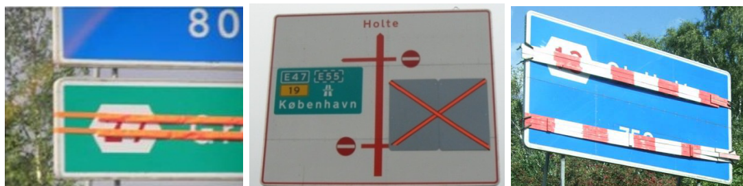
Figur 8.4 Eksempler på annullering af vejvisningstavler.
