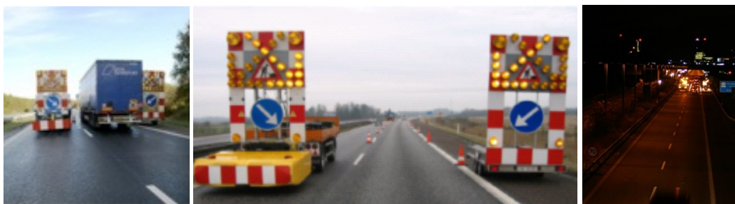
Figur 7.21 Eksempler på portopstillinger med afmærkningsvogne.
