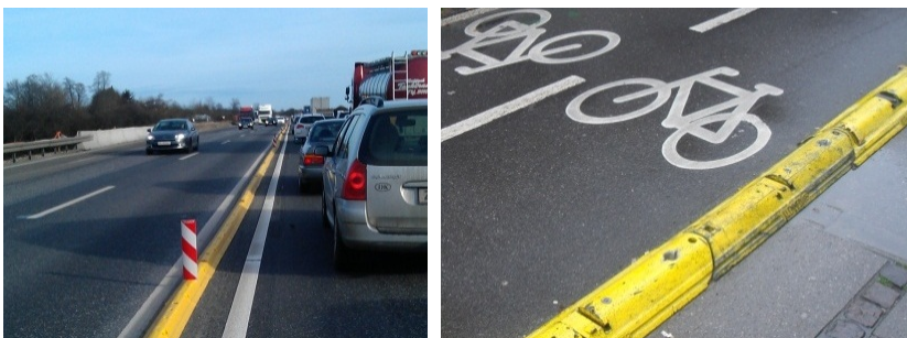
Figur 7.28 Eksempler på anvendelse af ledebjælke.
