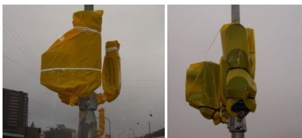
Figur 5.29 Eksempler på tildækning af lyssignaler med gule sække.
