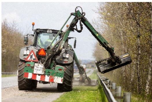
Figur 8.1 Eksempel på kørende vejarbejde i åbent land med beskyttelsesniveau 5. Maskinelt vejarbejde.
