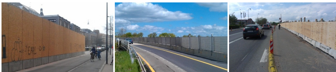
Figur 7.29 Eksempler på afskærmning mellem arbejdsområde og trafikområde.
